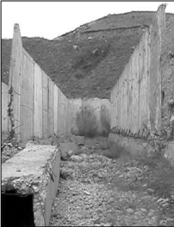
Очистная станция г.Спитак
